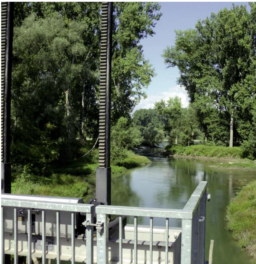
▲ Blick vom neuen Durchlassbauwerk in das Rheinvorland
