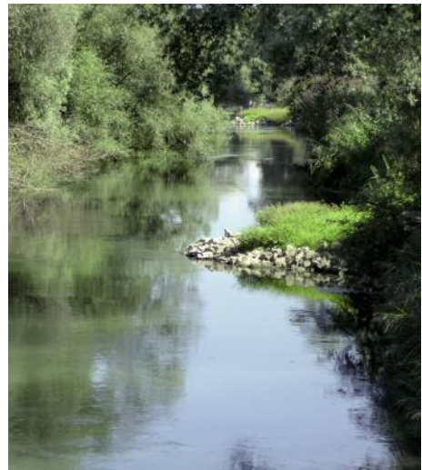
▼ Strömunglenker im Albkanal nach der Fertigstellung
