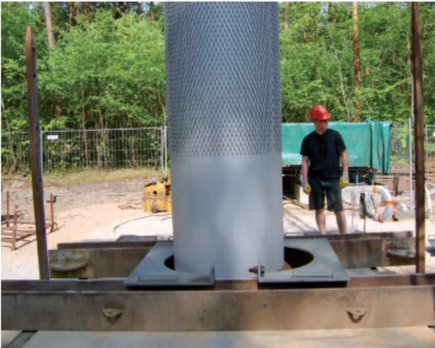
Abb. 9 Einbau von Schlitzbrückenfilterrohren DN 1000
