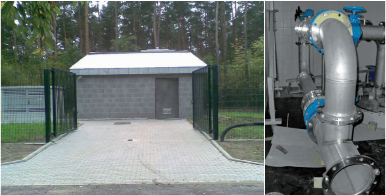
Abb. 6 Gebäude und Rohrleitungseinbau Brunnen 5
