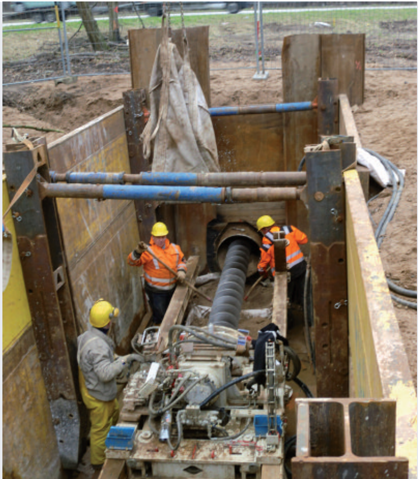
Abb. 11 Vergleich benutzter und unbenutzter Bohrkopf der Pilotbohrung, Rohrvortrieb unter der BAB 5 sowie Ergebnis nach Fertigstellung der Unterquerung
