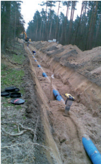
Abb. 7 Verlegung der Rohwasserleitung DN 400 GGG ZMU im offenen Rohrgraben
